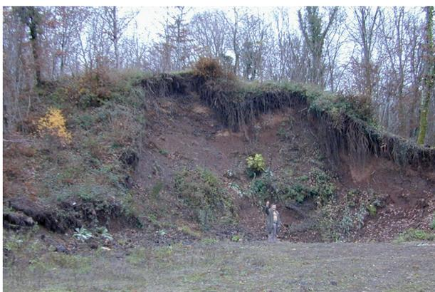
**Fig. 7.** Très gros monticule de déchets sidérurgiques, de plusieurs dizaines de mètres de diamètre et plusieurs mètres de hauteur, très partiellement conservé en milieu forestier actuel et ayant fait l'objet de nombreux prélèvements depuis la fin du XIX<sup>e</sup> siècle (Bois des Ferriers à Aillant-sur-Tholon; cliché J.-P. Piétak).
